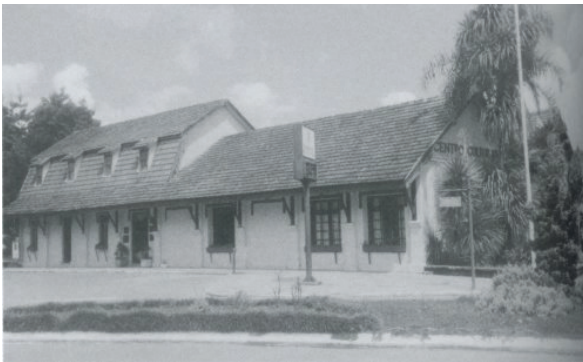
(c) Fachada norte.
