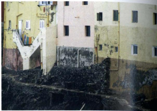
El estado en que se encontraban los revestimientos de conjunto de El Roque era considerablemente deficiente, estando afectadas tanto las pinturas de fachada e impermeabilizaciones, como los enfoscados.
