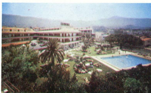
HOTEL LA PAZ **** Propietario: Hotel La Paz, S.A. Director: Agustín Avila Hernández
