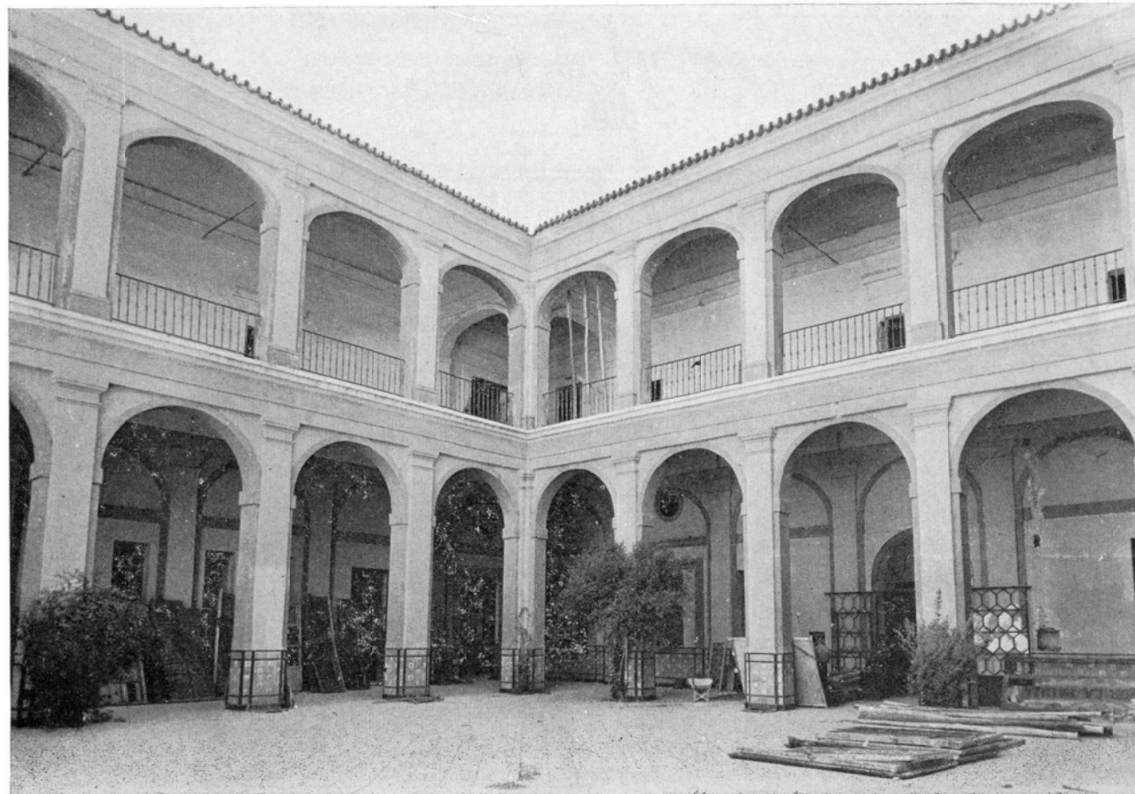
Patio del antiguo colegio de San Hermenegildo, de Sevilla, luego cuartel del Regimiento de Soria, hoy derribado. (Laboratorio de Arte, Universidad de Sevilla.)
