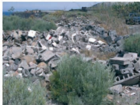
Restos de muro
