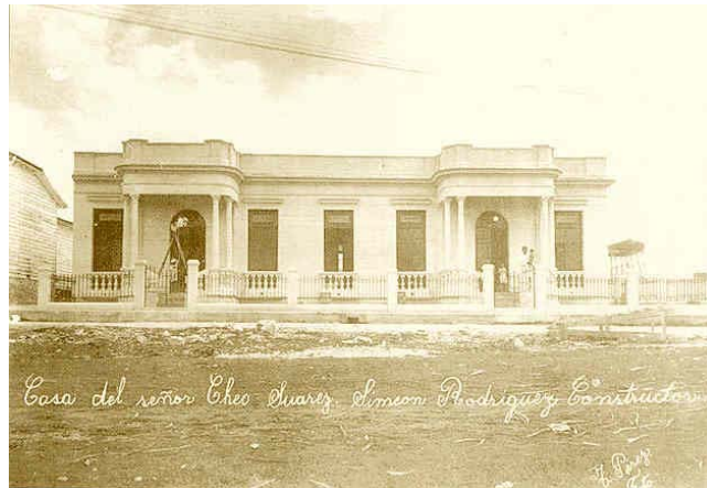
Fig. 26 y 27. Los mejores diseños de viviendas unifamiliares de nuestro maestro de obras: las casas de Marcelo Armas, arriba y la de Cheo Suárez, construidas en 1925, en Encrucijada. Fotografías de la época..
