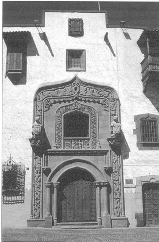
Portada verde. Debajo de la ventana, escudo verde de Diego de Muros, a la derecha el de Juan Rejón, a la izquierda el de Juan de Frías y, en lo alto, el de Gonzalo Argote de Molina
