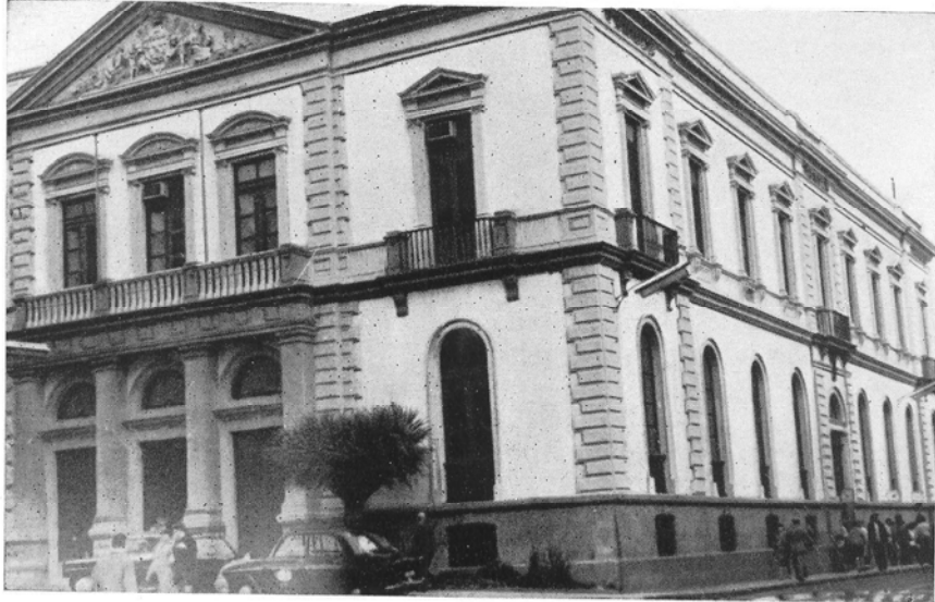
Antonio Pintor y Ocete. Fachada principal del Ayuntamiento. Santa Cruz de Tenerife (siglo XIX).
