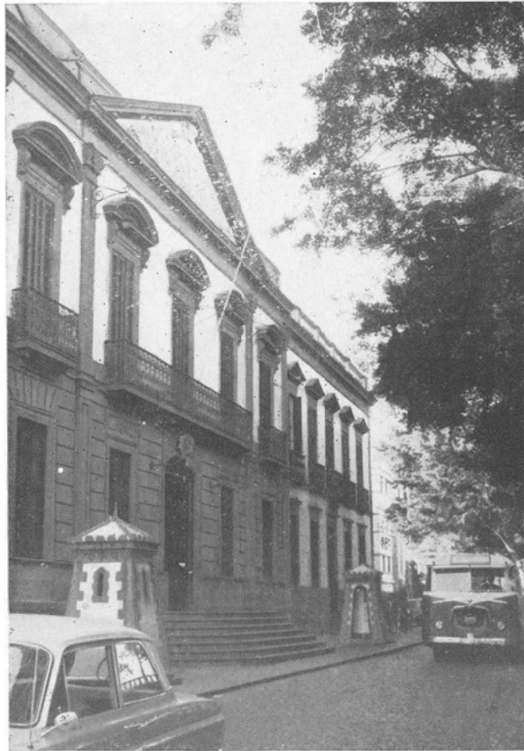
Domingo Sicilia González. Fachada principal de la Capitania General del Archipiélago. Santa Cruz de Tenerife (siglo XIX).
