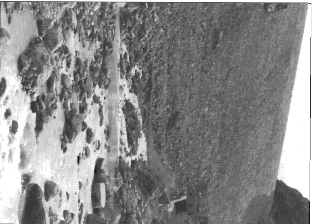
La presa de Siberio, enero de 1979, con el enorme caudal que perdía por la base de la escollera.
