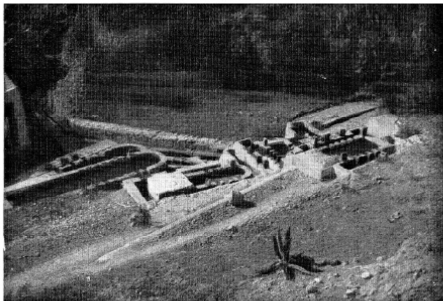
Heredad de Arucas. Su partididor está rodeado de otros para la venta de aguas.
