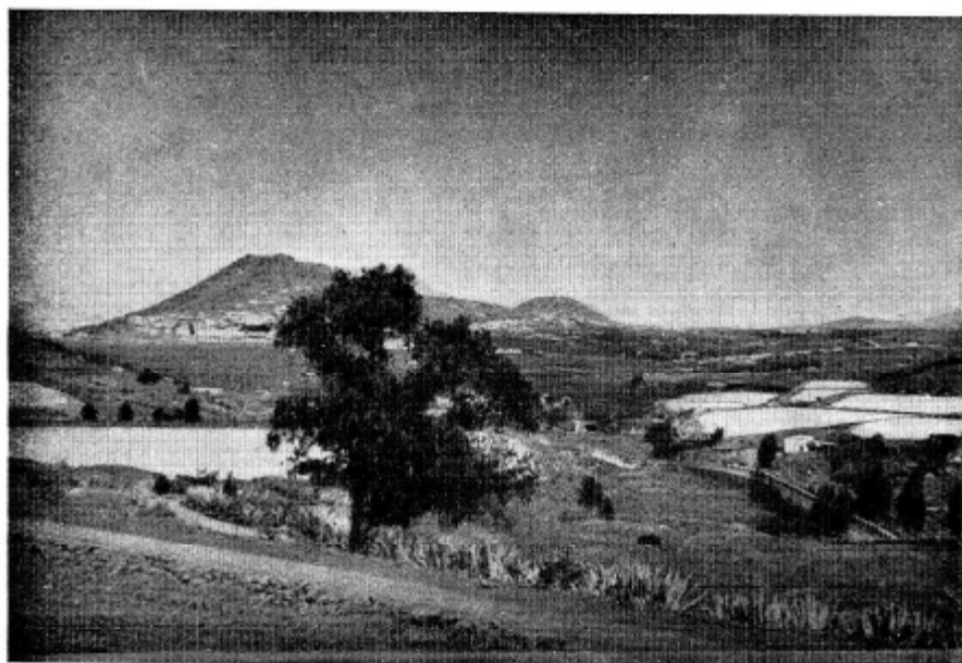
Estanques de arcilla (barrial) para aguas de invierno en Visique (Arucas).
