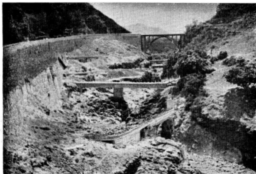
Barranco de la Angostura. En corto trecho le cruza un viaducto y cinco tuberías de hormigón armado.
