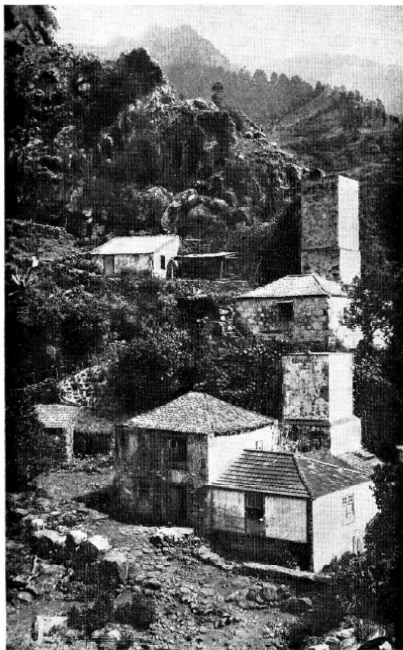
Aprovechando el desnivel de las acequias de las Heredades suelen instalarse molinos de «gofo». Barranco de las Nieves, en La Palma.
