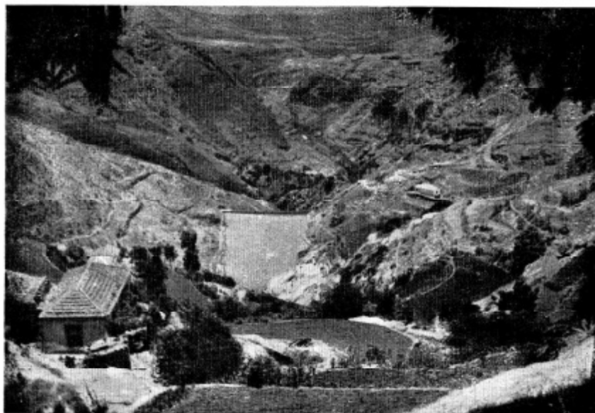
Presa de Antona de la Heredad de Las Palmas (en construcción).
