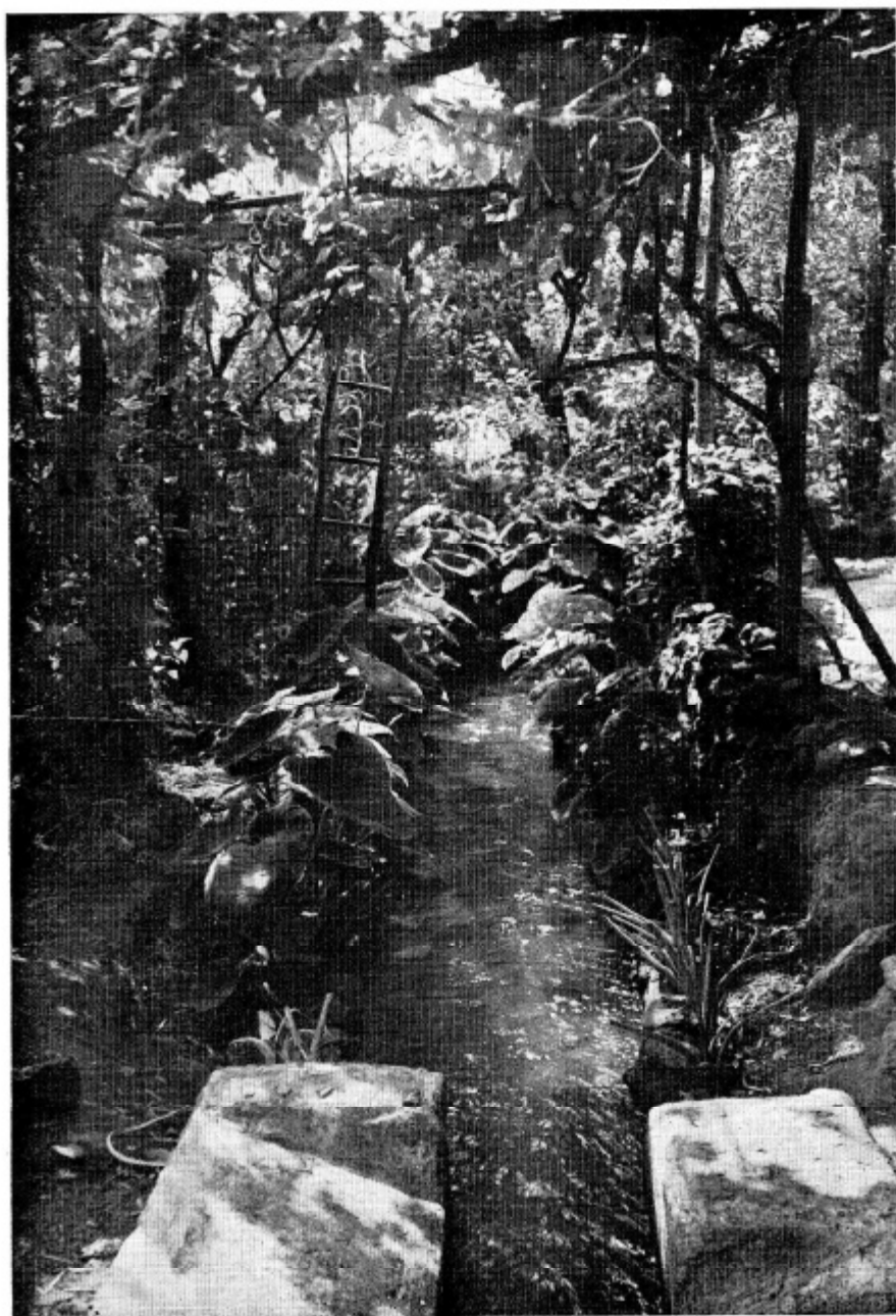
Acueducto mixto de tierra y obra de fábrica.
