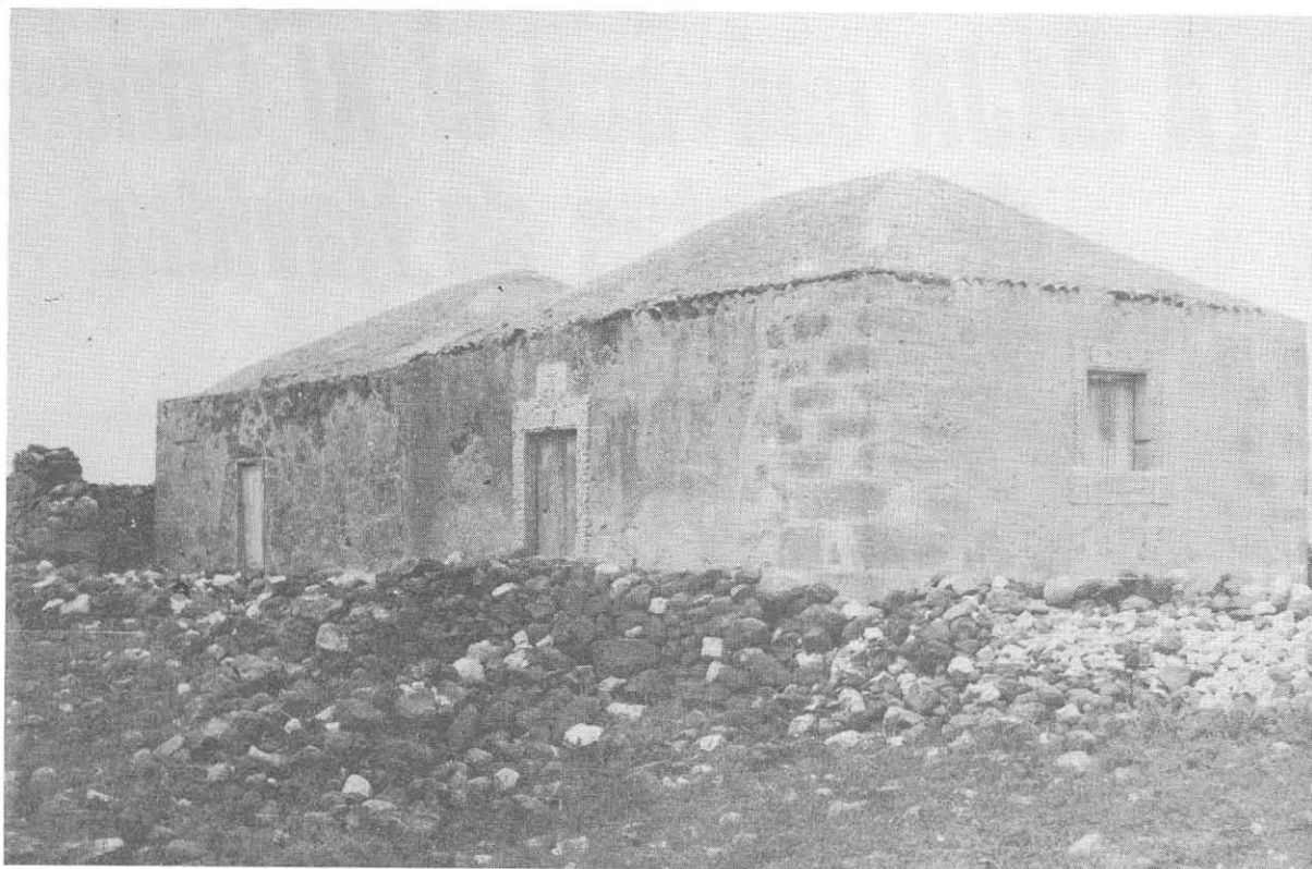
Antigua casa rural en Fuerteventura
