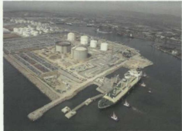
El hecho de que las profundidades entre a las Islas Canarias sean muy grandes hace imposible el uso de un gasoducto para importar el Gas Natural en forma gas, de ahí la necesidad de importarlo en forma licuada (a  $-160^{\circ}\text{C}$ ) y
