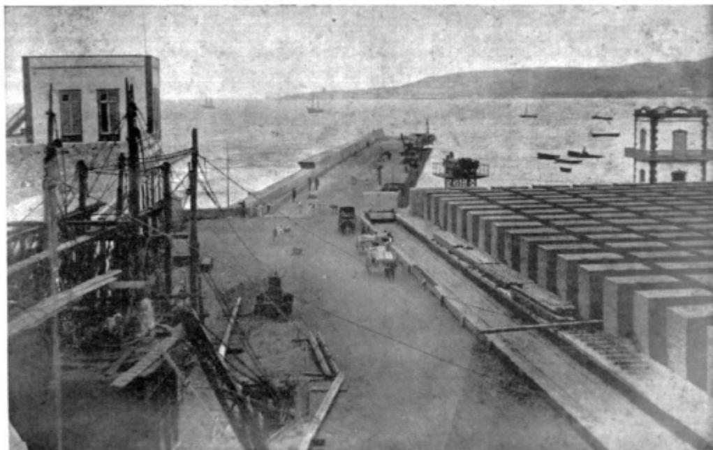
Explanada de bloques en el Muelle de la Luz
