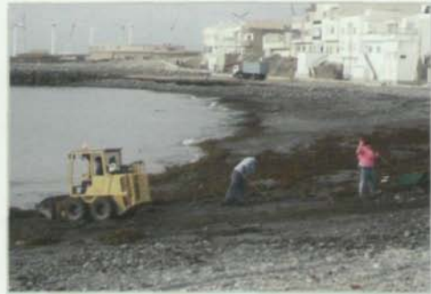
Foto 29 Retirada del arribazón de algas de la playita que se encuentra al abrigo de ambos muelles frente al pueblo de Pozo Izquierdo con la ayuda de una minicargadora. Al fondo se puede observar el camión grúa con el sistema de agarre pulpo retirando los arribazones de algas de la zona de callaos .
