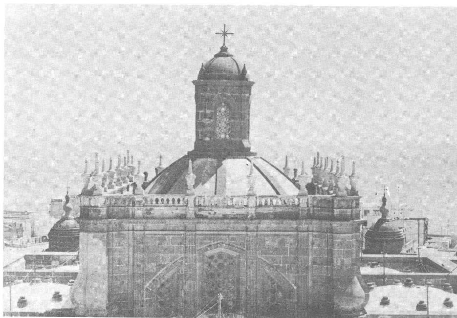
La cúpula del cimborrio de la Catedral tiene visibles parches de cemento que deben ser sustituidos por la piedra del conjunto
