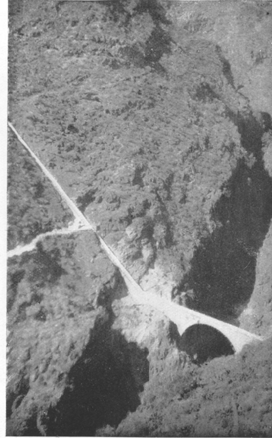
10.—El canal, salvando el barranco de «El Río» en el término de Arico.
