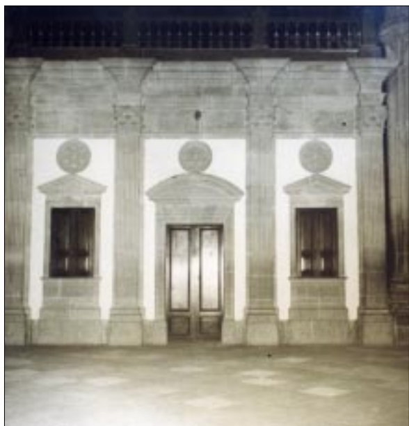
IMAGEN 6.—Detalle parcial del alzado lateral del Coro.
