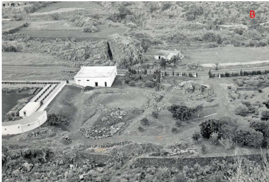
Figura 9. A) Diseño-boceto del Jardín de Cactus realizado por Zoë Bramwell, dentro del 'Proyecto Paisajístico del Jardín Botánico Canario' del Cabildo de Gran Canaria. B) Obras de preparación del Jardín de Cactus en 1975. Dentro de este espacio quedaron algunas plantas de los antiguos cultivos de frutales como Citrus limon (L.) Burm. f. o Morus nigra L. Hacia la derecha y en primer plano se observa una parte del Jardín Botánico con un bosque de plantas donadas por la iniciativa popular.
