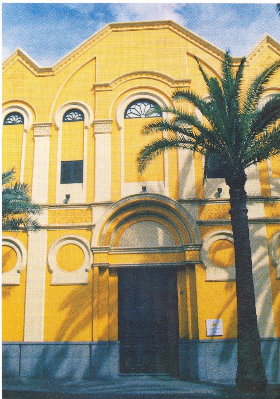
Fachada Sala de Teatro (1º Mayo).
