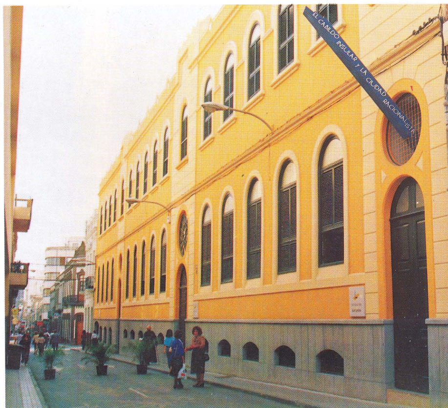
Fachada calle Pérez Galdós.
