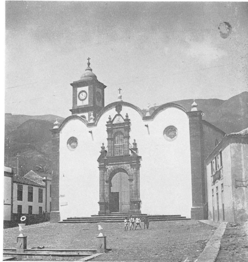
Fachada de la iglesia de San Pedro. Güímar
