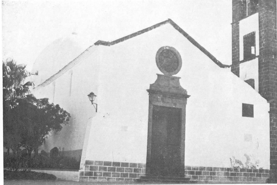
Fachada de la iglesia de San Pedro. El Sauzal
