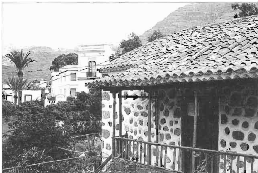
FIG. 4.—Edificio del curato de Mogán, construido en 1817.
