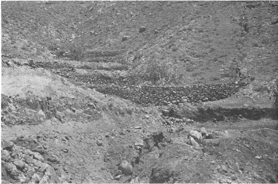
Fot. 1. —La cabecera de los barrancos es generalmente aprovechada en Fuerteventura para captar las aguas de escorrentía y crear suelos; son los llamados «nateros», dedicados a cereales y frutales
