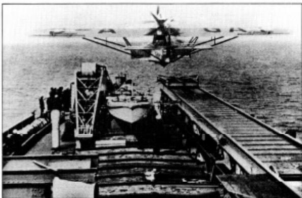
73 Catapultado del Dornier Wal desde el Schwabenland. Una rampa con un mecanismo de catapulta permitía el rápido despegue del hidroavión con su carga.
