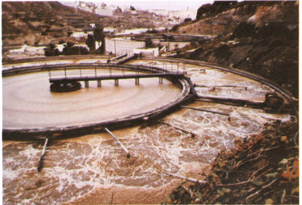
f. 26.—Depuradora de aguas residuales de Las Palmas
