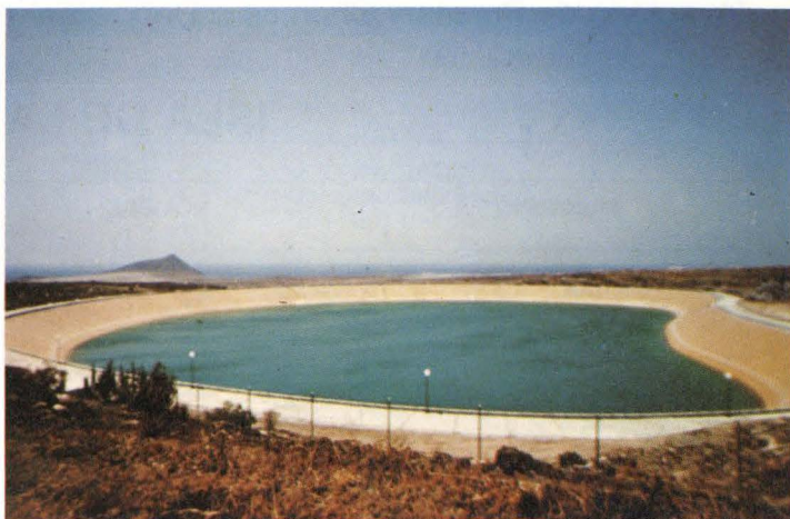
f. 25.— Depósito regulador de El Saltadero. Tenerife
