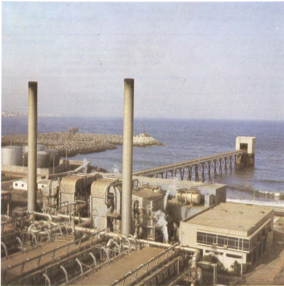
f. 27.—Planta potabilizadora de agua de mar en Las Palmas de Gran Canaria
