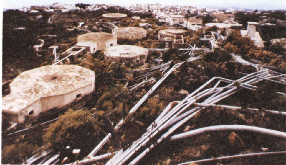
f. 28.—Caótica distribución de aguas. Tanquetas de reparto de Aripe. Isla de Tenerife.
