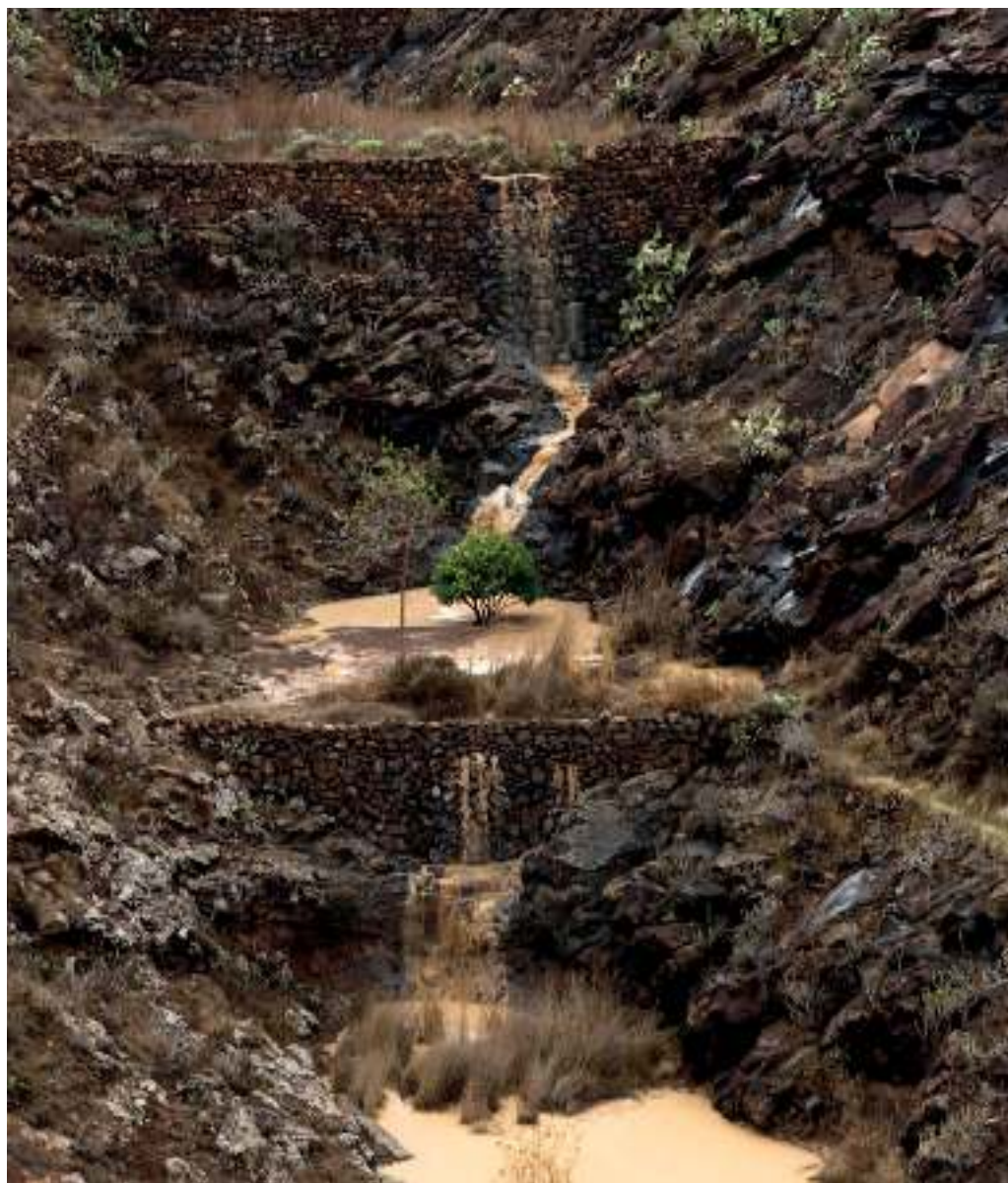
Figura 15: Traveseros ya en desuso desaguando en el Valle del Palomo. Fotografía cortesía de J. Farray.
