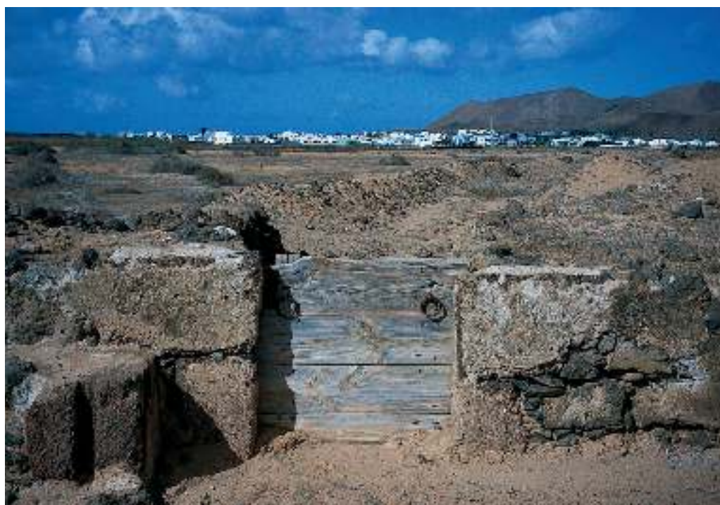
Figura 9: Portada a modo de guillotina para entrar agua a las gavias en la Vega de Guatiza. En la parte inferior izquierda de la imagen se puede observar parte de la estructura encargada de obstaculizar y derivar la avenida principal de las aguas hacia dicha portada.
