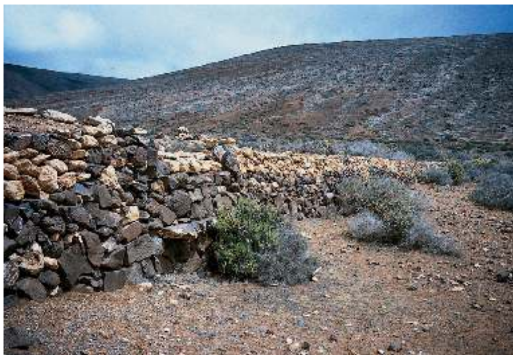
Figura 10: Pared de una gavia abandonada en la Vega de San José, Teguiise, con signos de haber sido encabezada. Las lajas de piedra sobresalientes al pie del desagüe evitaban que el agua incidiera directamente sobre la base de la pared y la socavara.
