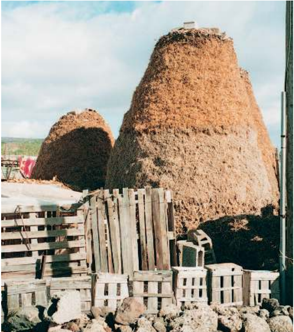
Figura 55: Pajeros recientes en los alrededores de una casa de campo en el pueblo de Teseguite. De la variada coloración que muestra el que se encuentra en un primer plano se deduce que para su levantamiento se empleó paja procedente de diferentes cosechas. La fotografía es meramente ilustrativa pues no se trata de un pajero de paja de cebada.
