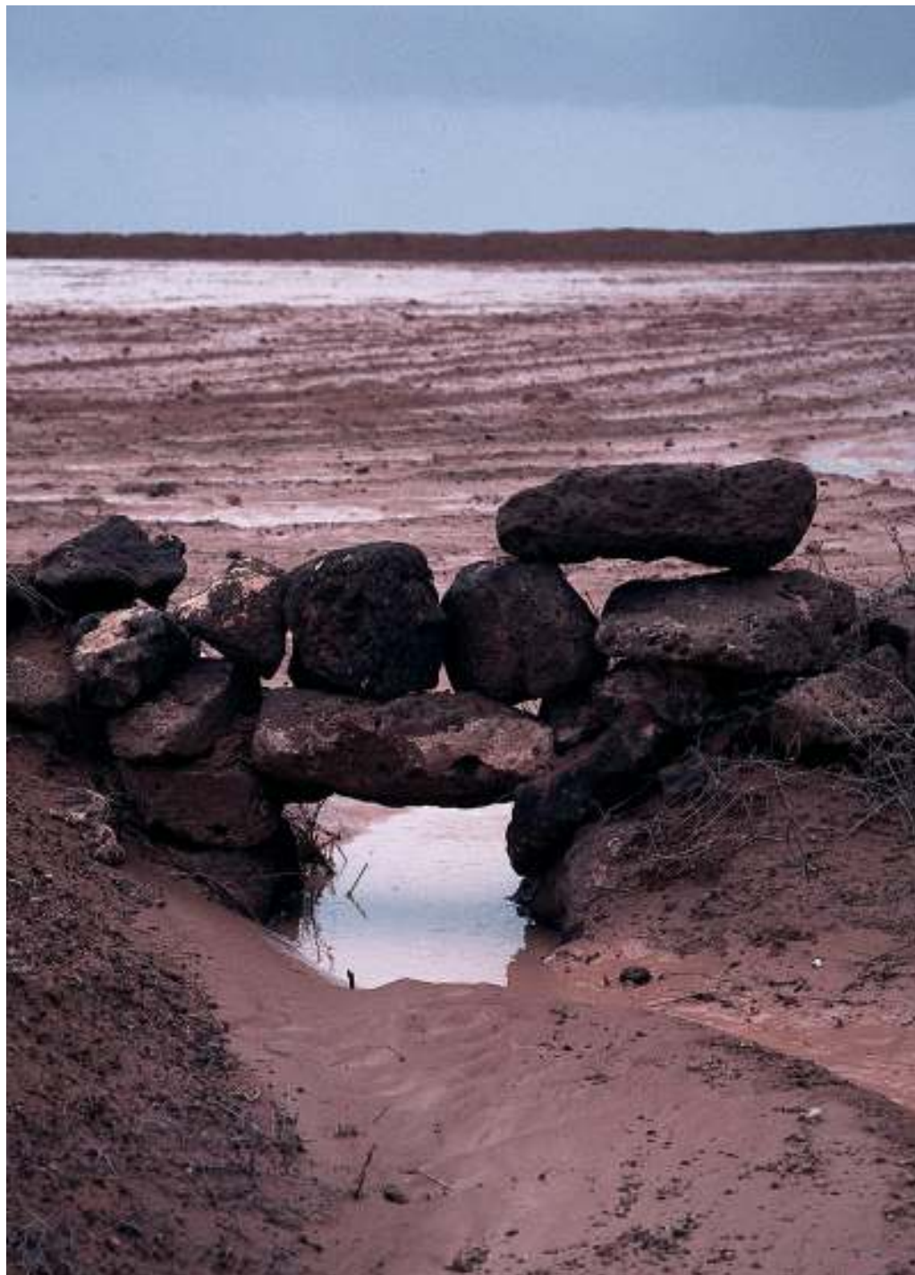
Figura 8: Caño de entrada a la gavia todavía con los restos del agua que encauzó hasta la misma. Obsérvese detrás la labor de arada efectuada de manera perpendicular a la irrupción del agua en el recinto. Gavias de señor Domingo Umpiérrez, Teseguite.
