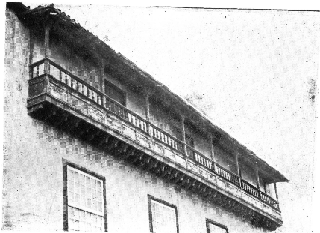
Casa de don José Olivera en La Laguna. Balcón de la fachada
