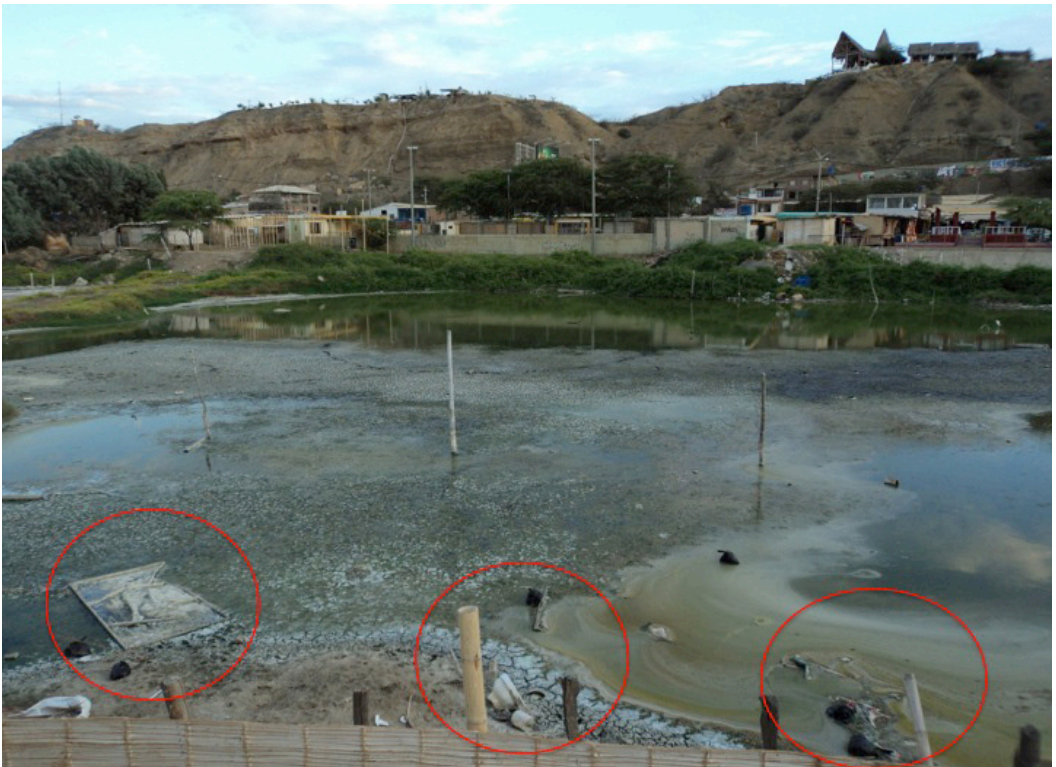
Figura 4. Degradación ambiental en el humedal de Máncora, 2011 (foto del autor).
