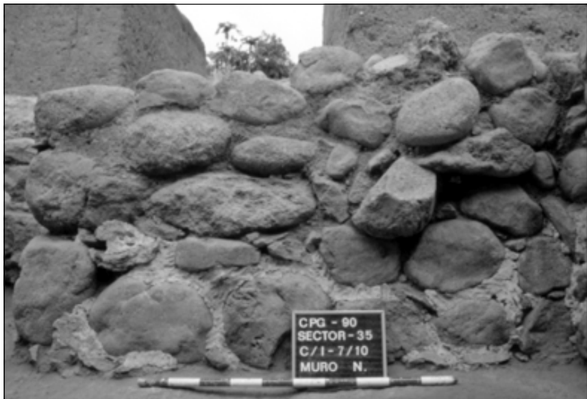
FIGURA 9.—Detalle del llagueado de mortero de una casa indígena.
