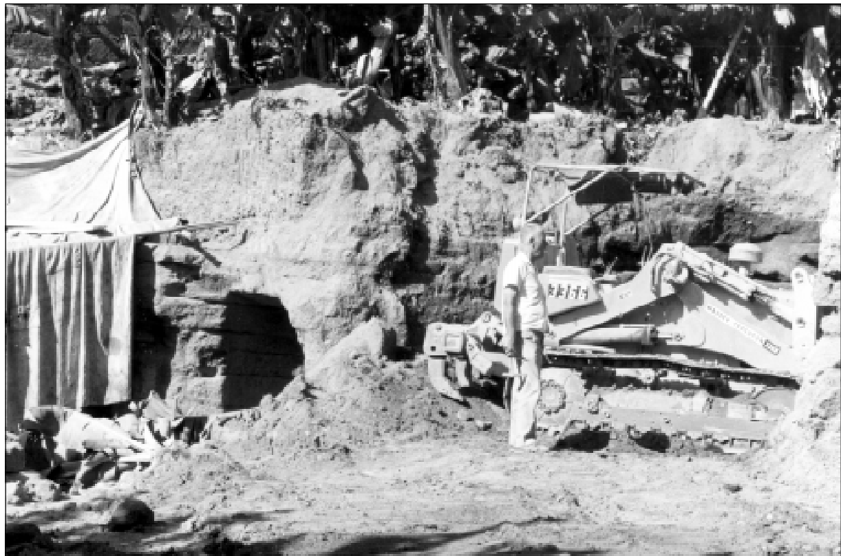
FIGURA 2.—Vista de los trabajos de desmonte realizados en 1970.
