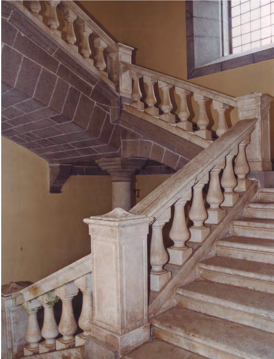
Fig. 33. Escalera de mármol, abalaustrada en cuatro tramos con rellanos del mismo material y apeado el cuarto tramo con una columna toscana. Siglo XVIII. Ordenada su construcción por el V marqués.
