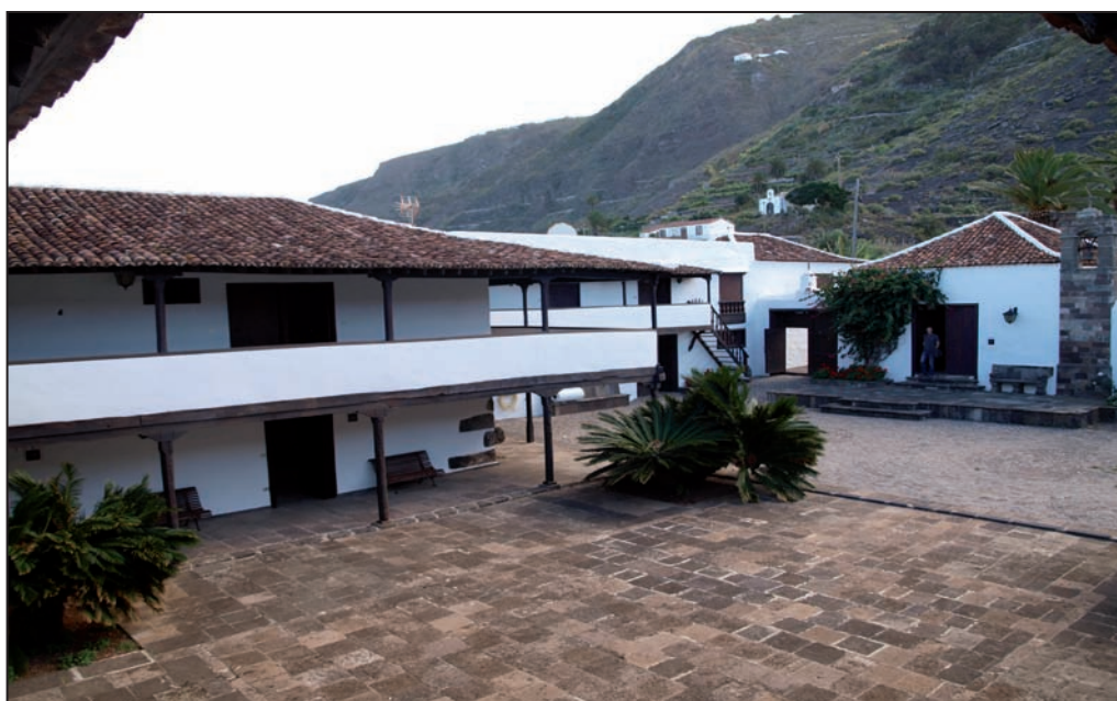
Figura nº 3. Vista actual de parte del patio, entrada principal, Ermita y Oficinas.
