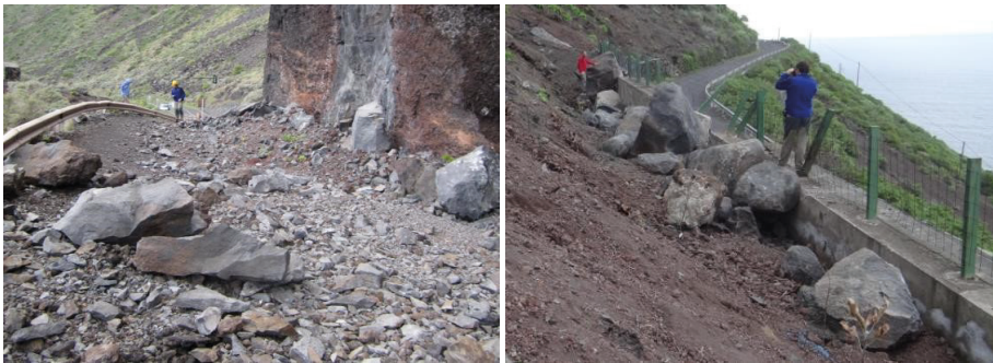
Figura 9. Detalle de las morfologías de los fragmentos de bloques desprendidos en dos puntos de la Carretera de Sabinosa, El Hierro.
