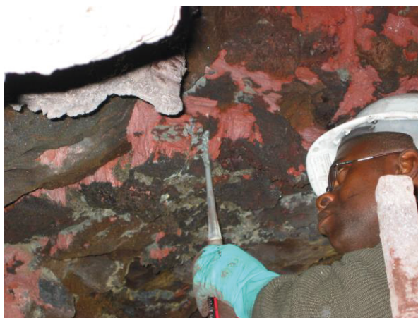
Figura 25. Instalación manual de la resina mediante cánula.
