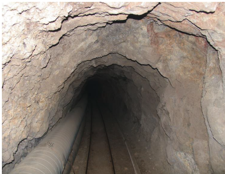
Figura 1. Sección de una galería en Tenerife.
