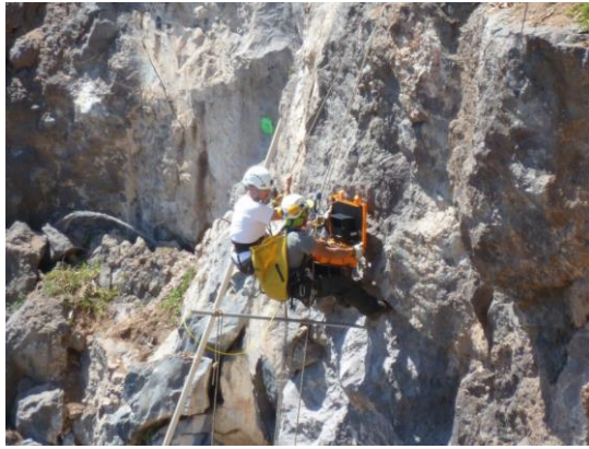
Figura 15. Auscultación de las perforaciones mediante videocámara.
