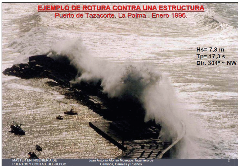
Figura 12. Temporal en el puerto de Tazacorte en enero de 1996 (Fuente: Pagina web de Puertos del Estado).
