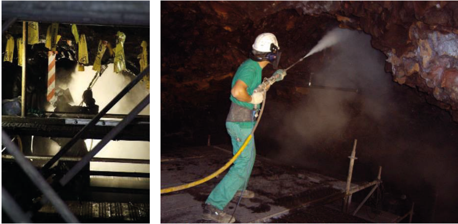
Figuras 14 y 15. Hidrodemolición y lavado con agua a muy altas presiones
