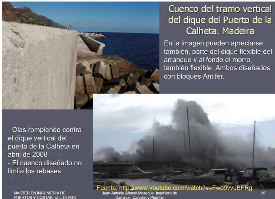
Figura 17. Cuenco del tramo vertical del dique del Puerto de La Calheta (Madeira).
