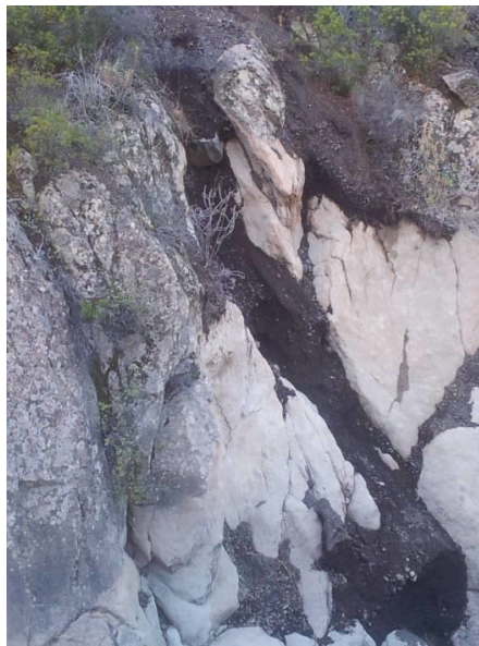
.Figura 3. Relleno de una grieta en macizo rocoso.
