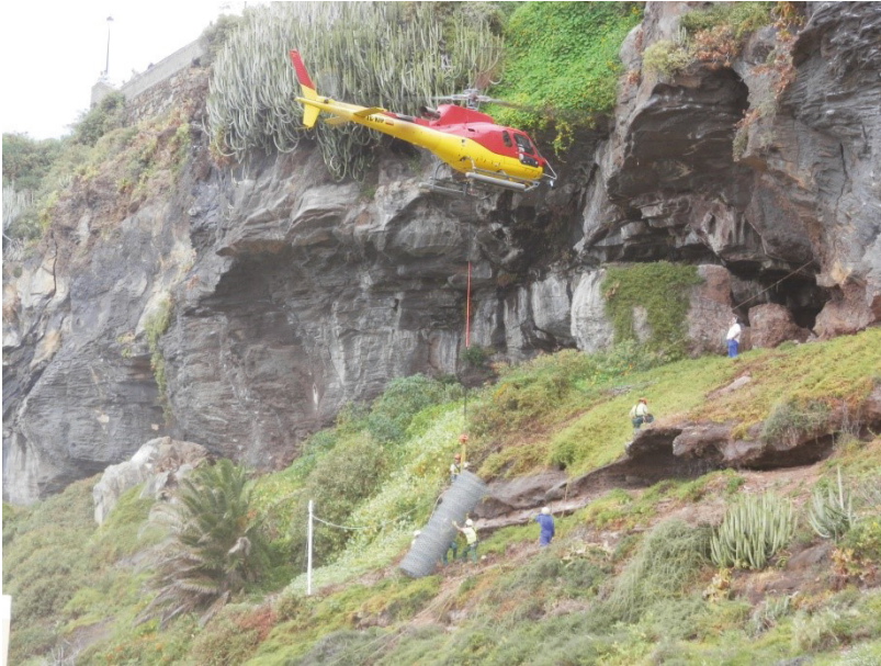
Figura 10. Trabajos de montaje de pantalla dinámica con helicóptero.
