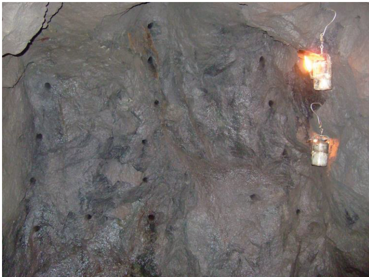
8. Perforación para voladura – Galería “Montaña Enmedio” (Tenerife)
