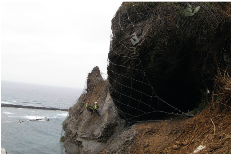
Figura 11. Ejemplos de bloques estabilizados.
