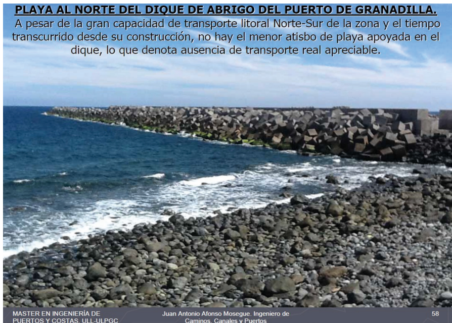
Figura 25. Playa al norte del dique de abrigo del Puerto de Granadilla (Tenerife).
