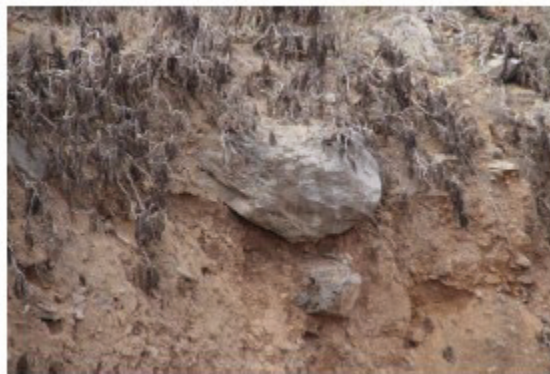
Figura 3. Inestabilidad por bloques sueltos a media ladera.
