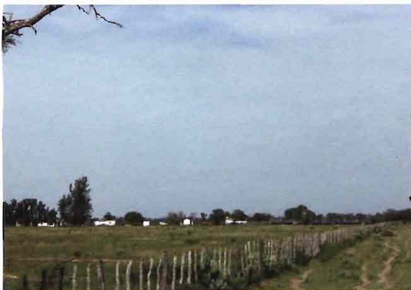
Vista general de la casa e instalaciones
