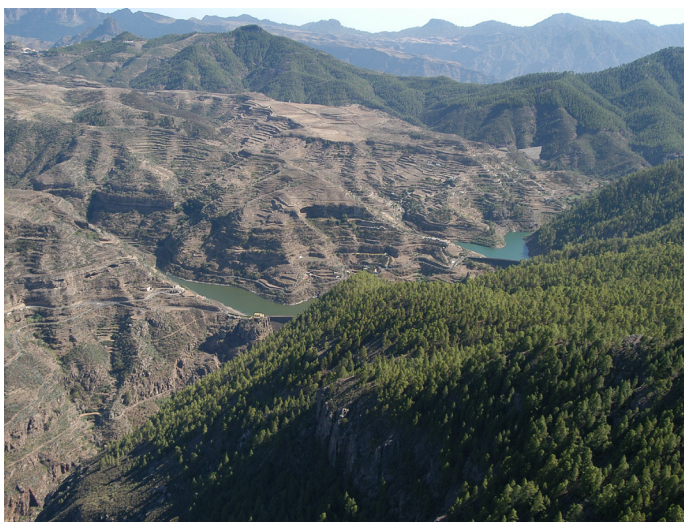
Final del cauce de Barranco Hondo en la Presa de los Pérez
