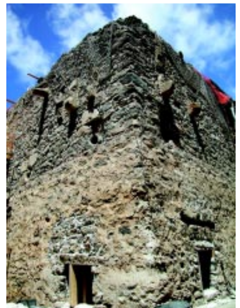
La Torre de Alonso de Fajardo descubierta tras la excavación.
