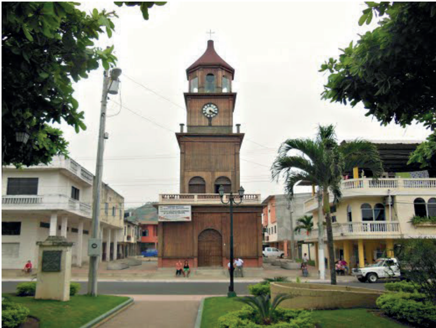
Figura 3: Torre del reloj de la ciudad de Calceta.
