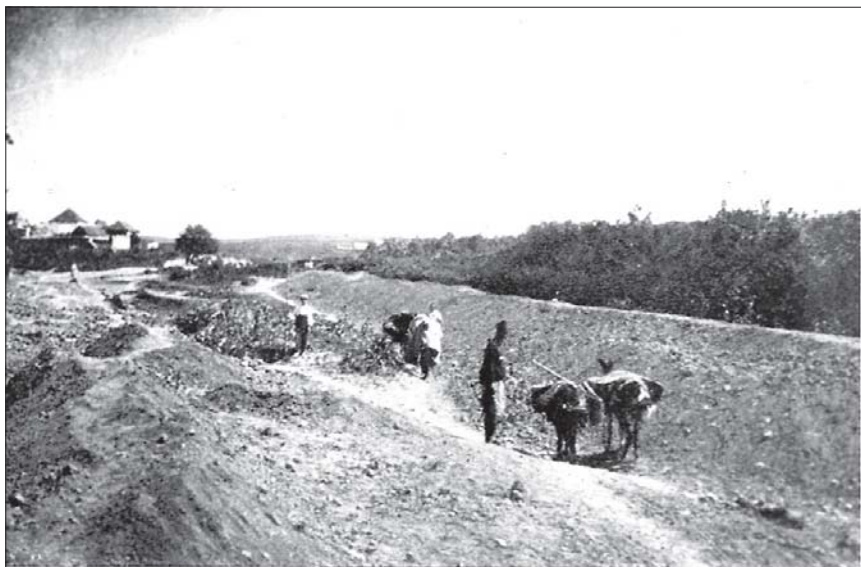
3. Proceso desecación de las charcas palúdicas. A) Relleno de las charcas.
