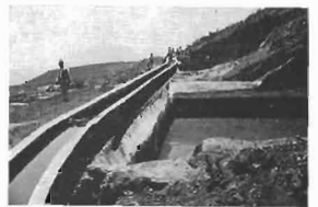
Una sección del canal del Sur.
