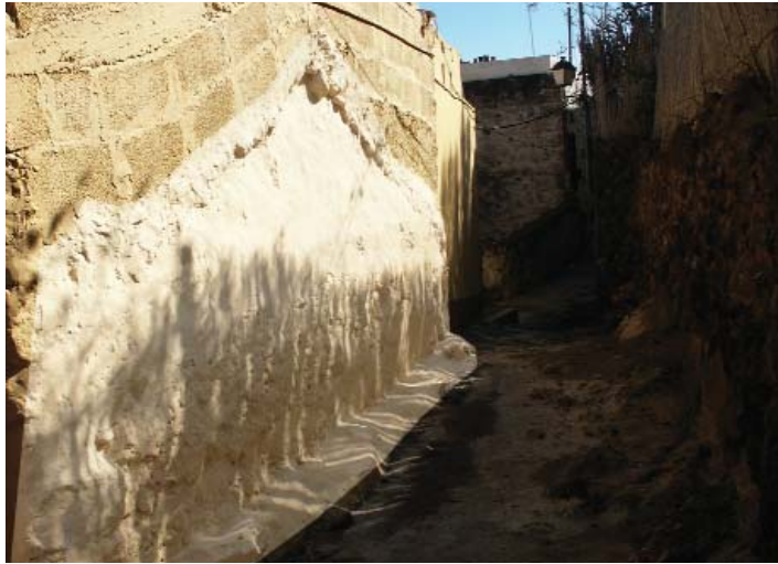
Casa antigua en la calle del Molino, con techo a dos aguas, alterada por construcciones posteriores, que puede ser parte del Ingenio.
