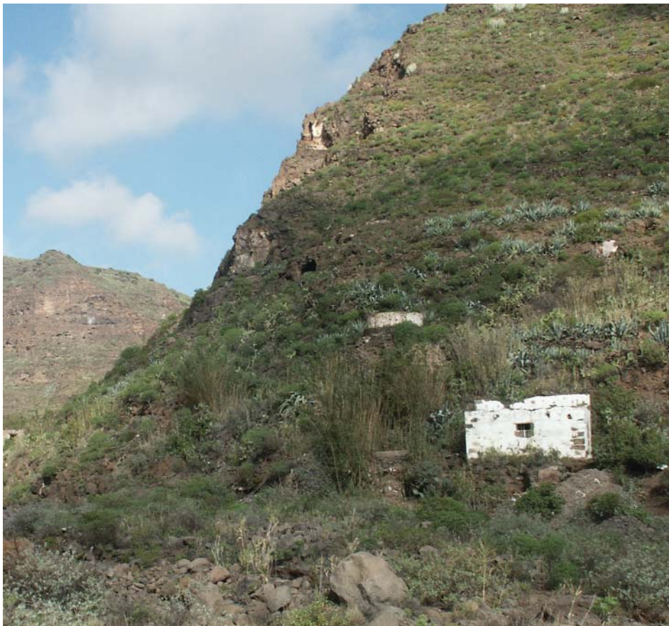
En primer plano Caja de Repartos en Guayadeque. Detrás el molino de Francisco Perera.
