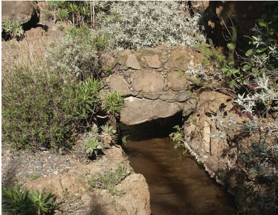
Entre la Caja del Pleito y la caja de Reparto aparece una estructura de piedra y argamasa en forma de arco sobre la acequia que continúa hacia el cauce del barranco. Un estudio arqueológico podría determinar su finalidad. Desde este lugar se contempla la infinita belleza de Guayaqueque.
