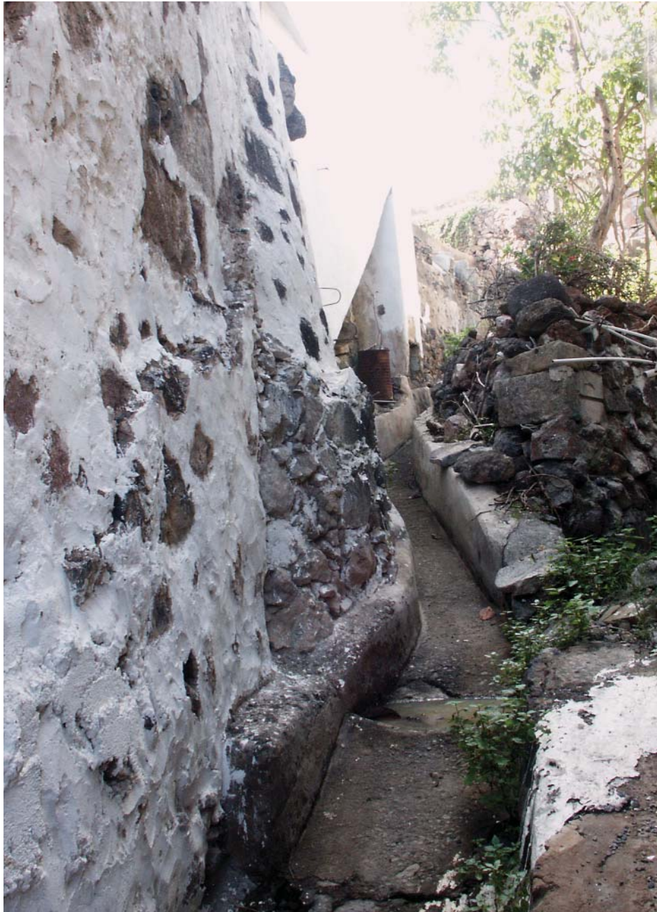
Herido o salto de agua que movía los molinos de la Villa de Ingenio. en el centro de la imagen se pueden apreciar posibles restos del cubo del molino de Juan Álvarez (siglo XVI)
