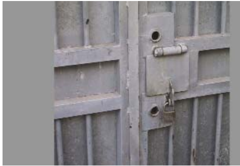
Orificios de las dos cerraduras de la Caja de Reparación. Los dos heredamientos disponían de una llave diferente y solo se podía abrir en presencia de los rancheros de cada comunidad. Esta medida se toma para evitar las posibles manipulaciones en las bocas de reparto.
