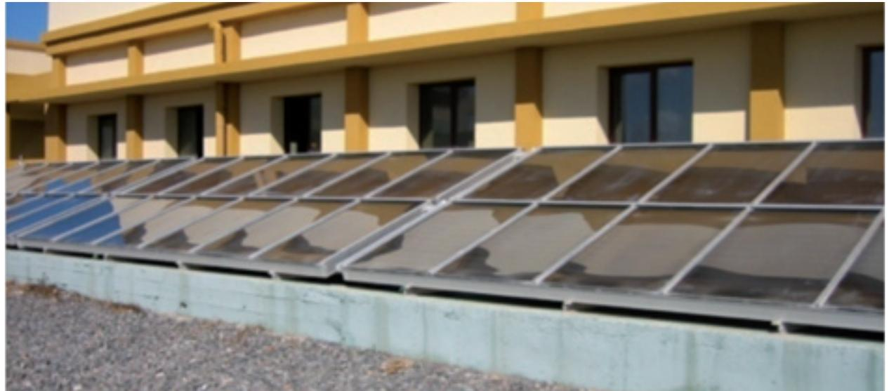
Figura 22.2. Captadores solares de placa plana de gran superficie
