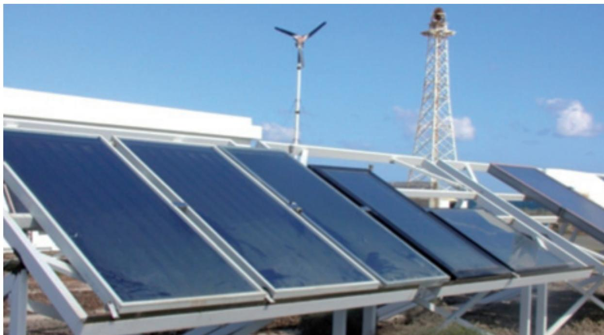
Figura 22.1. Captadores solares de placa plana de distintos tamaños.
