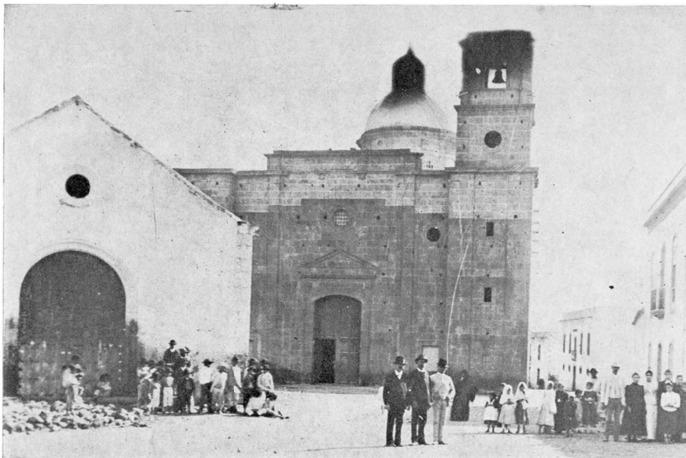
En esta foto, de principios de 1889, aparecen el templo primitivo, que no acaba de derruirse, y el templo nuevo, recién abierto al culto, antes de su terminación.
