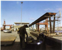
MONTAJE DE PASARELAS PARA EMBARQUE DE PASAJEROS EN LA ESTACION MARITIMA.
