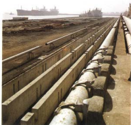
CONSTRUCCION DE GALERIAS SUBTERRANEAS PARA COLOCACION DE TUBERIAS DE SUMINISTRO.
