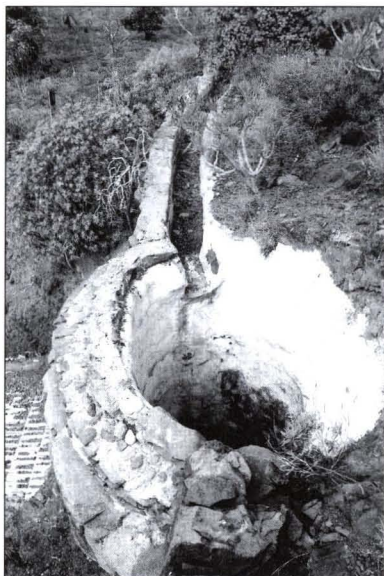
Fig. 8. La canal y el cubo del molino del heredamiento de Cuevas Caídas, Mogán, 1999.
