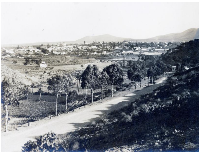
Figura 14.- Carretera Las Palmas-Telde y puente de los siete ojos. Con eucaliptos en hilera de unos 40-50 años. Foto: Teodoro Maisch, 1925-30. FEDAC.
