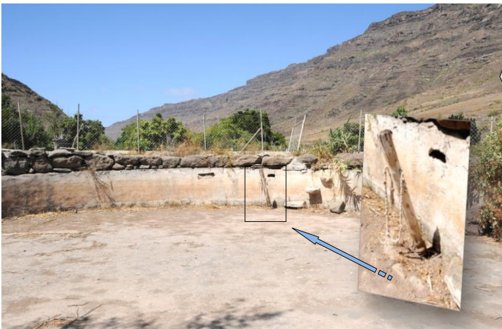
Tanque de la Mina de Las Casillas: un albercón de planta circular (12 m de diámetro) con sistema de salida del agua de bomba antigua (palo-tapón en imagen superpuesta), modelo muy común en esta comarca.
