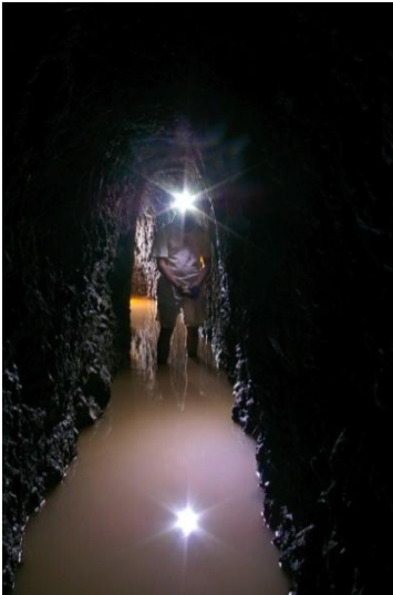
Arriba: localización de la Mina de Los Llanetes | INFOGRAFÍA DE GRAFCAN. ❶ Boca de la mina ❷ Campana ..... Trayecto aproximado del túnel. Abajo: tramo de túnel de conducción excavado en roca y trayecto de túnel de filtración en el subálveo entibado con paredes de mampostería enripiada y techado con lajas | OCTAVIO FERNÁNDEZ, EQUIPO DE ESPELEÓLOGOS TEBEXCORADE , 2007.
