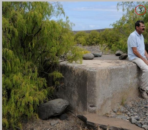
3. Exterior de la anterior campana. Presenta un brocal perfectamente enfoscado y con punta de tajamar ante la corriente de las aguas.
