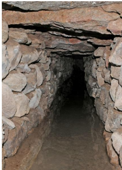
Perspectiva interior de la Mina de Pino Cortado , Tasarte.
