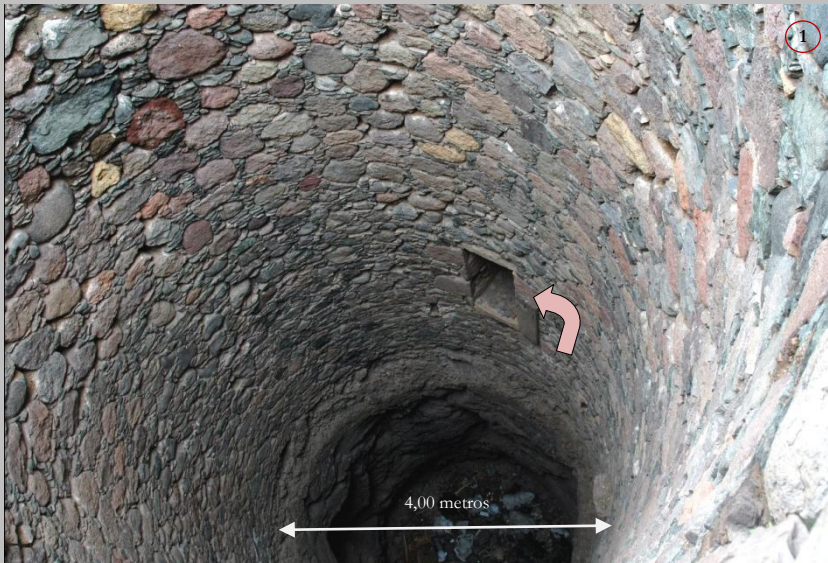
1. Pozo de regulación de la Mina de la Acequia Blanca . La flecha señala el túnel de conexión con la mina.
