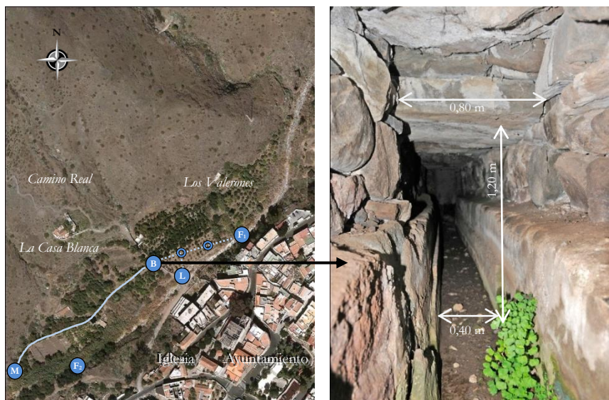
Izquierda: localización de la Mina de Los Valerones , junto al pueblo de Mogán. Derecha: detalle de boca de la mina con su canal de desagüe.
