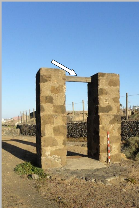
Brocal de campana con campanario , dos columnas de cantería que sostienen la viga de madera, señalada con la flecha, donde se colgaba la polea y la campanita de aviso. Mina de La Pardilla . Telde | COLECTIVO TYLDET.
