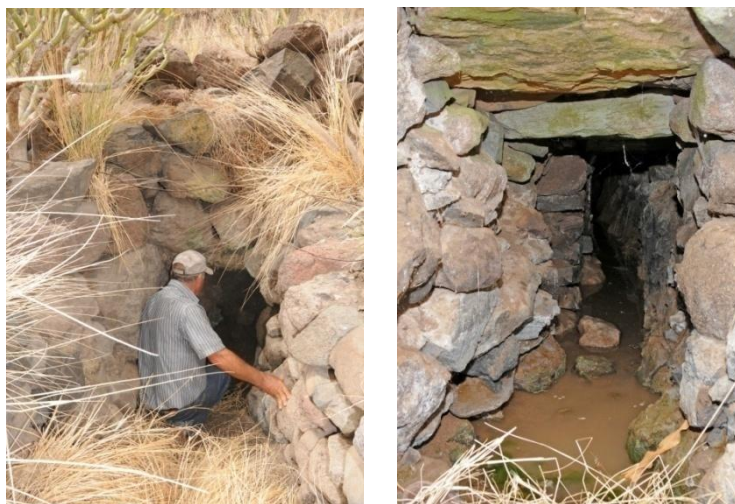
Mina de la Fuente de El Tarabalillo . Boca e interior de la galería filtrante.
