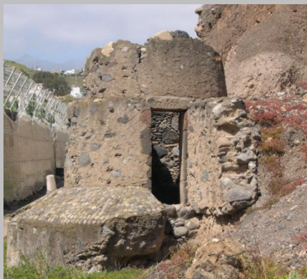
Curioso brocal de campana, a cielo abierto, con puerta lateral de entrada. Mina de Zamora , en Telde | JUAN ISMAEL SANTANA 2002.
