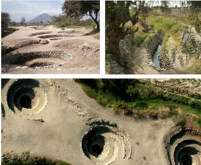
Tres perspectivas de los puquios de Nasca: 1. Panorámica lateral de los ojos; 2. Zanjas de drenaje y conducción del agua; y 3. Vista aérea de los ojos en rampa de caracol.
