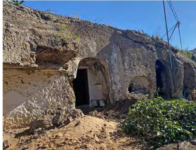
Afecciones en el roso: grietas por vegetación y poste de tendido eléctrico, disgregación por erosión y humedades por capilaridad.
