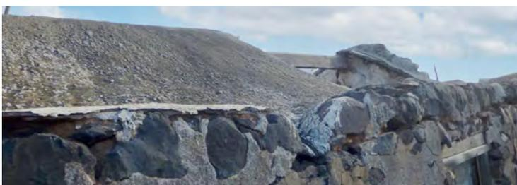
Detalle de evacuación de aguas del faldón en cubierta a dos aguas de cal.
