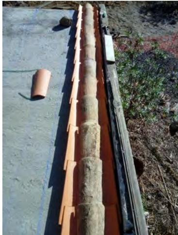
Imagen de colocación de tejas originales recuperadas, cobijas, con nuevas tejas a canal (las tejas originales eran insuficientes por deterioro del tejado original), Casas del Fondo, Bandama.
