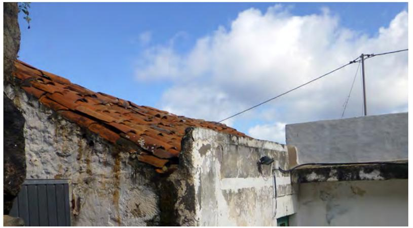
En las cubiertas a dos aguas, el remate del faldón hacia el muro hastial también puede ser simple o doble, con dos hiladas de tejas superpuestas y colocadas a junta corrida.
