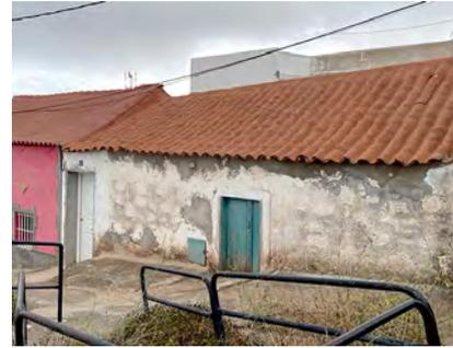
Cubierta de tejas reparadas con pintura impermeabilizante.
