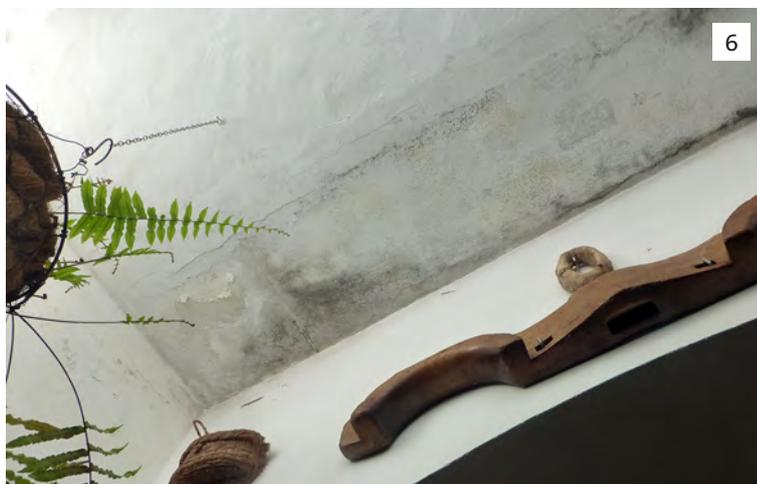
4. Desmantelamiento de horno; 5. Condensaciones por uso de materiales inadecuados y falta de ventilación; 6. Colonización de mohos y hongos.
