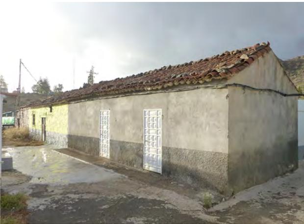
Rehabilitación en edificación tradicional rural. La cubierta se mantiene, pero se enfosca con mortero de cemento, se coloca una tirolesa en la parte inferior de la fachada y se sustituyen las carpinterías por puertas de aluminio, materiales no traspirables ni adecuados.
