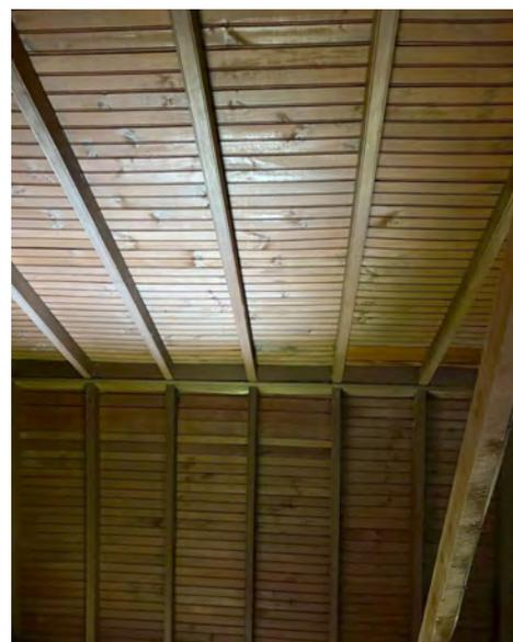
Entrevigado con paneles prefabricados de madera en cubierta de par e hilera con solera y tirante. Vigas tratadas con lasur coloreado.
