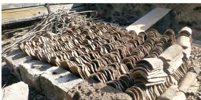
Tejas y *tillas* recuperadas y almacenadas para su posterior recuperación en cubierta restaurada.
