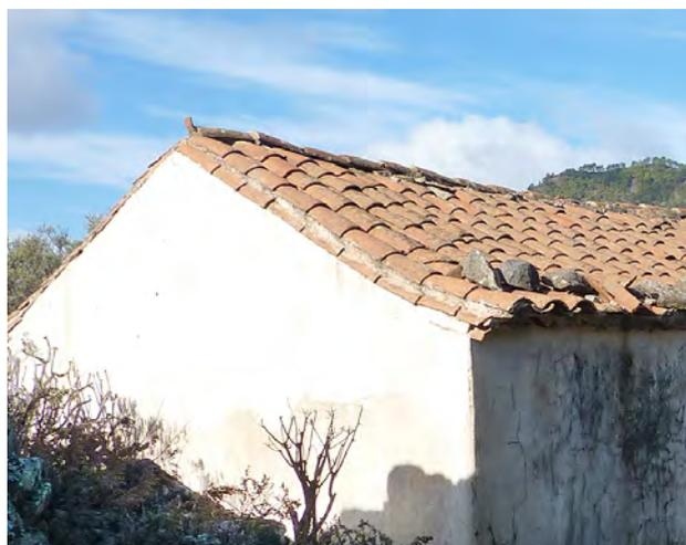
Imagen de pieza de remate de cumbre hacia muro hastial.
