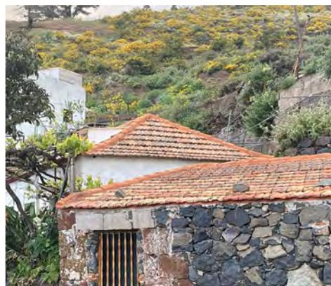
En las viviendas con cubierta a cuatro aguas y de influencia urbana, especialmente en las de dos plantas, es frecuente que el alero hacia la fachada principal (o fachadas principales en caso de tener dos) sea doble, triple o no exista, quedando el borde del faldón oculto para presentar una fachada más académica. En el resto de fachadas, a las que se adosan alpendres o quedan ocultas, el alero es siempre sencillo.
