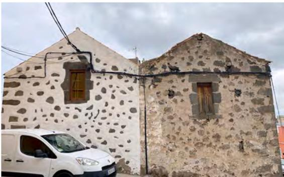
Ejemplo de rehabilitación de cubierta (a la izquierda de la imagen) donde no se respetan los valores de la cubierta: altura de la cumbre, proporciones y la curvatura del alero.
