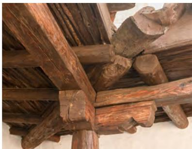
En ambos casos, se resuelven estructural y constructivamente con pares que se apoyan en vigas frontales y entrevigado de *tillas*, cañizo o tablas, en función del material empleado en la cubierta de la vivienda. Todo el alero se apoya en pies derechos de madera, que a su vez se apoyan en bases de cantería colocadas en el terreno, o bien, en un murete bajo que cierra el patio frontal.
