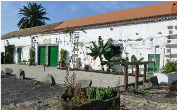
Cubierta a la que se le ha retirado la teja y se hace una torta de mortero de cemento y pintado con pintura plástica, material no transpirable ni adecuado
