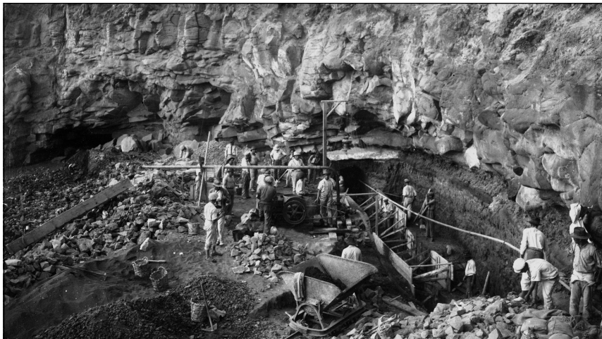
1. Construcción del alcantarillado en el Puerto de la Luz. Las Palmas de Gran Canaria. 1928. Teodoro Maisch. Gelatina. 15 × 22 cm.
