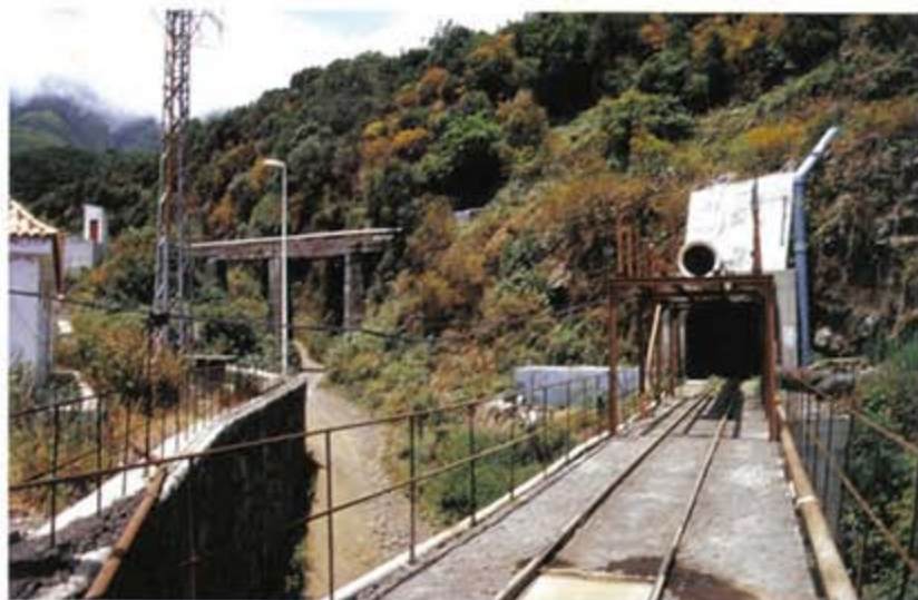
Foto 7.- Boca de entrada del Túnel de Trasvase. (Foto: O. Fernández).
