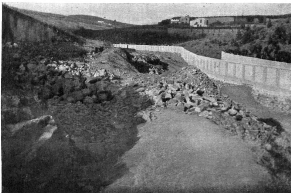
Trabajos iniciales de sorriba cortando la montaña
