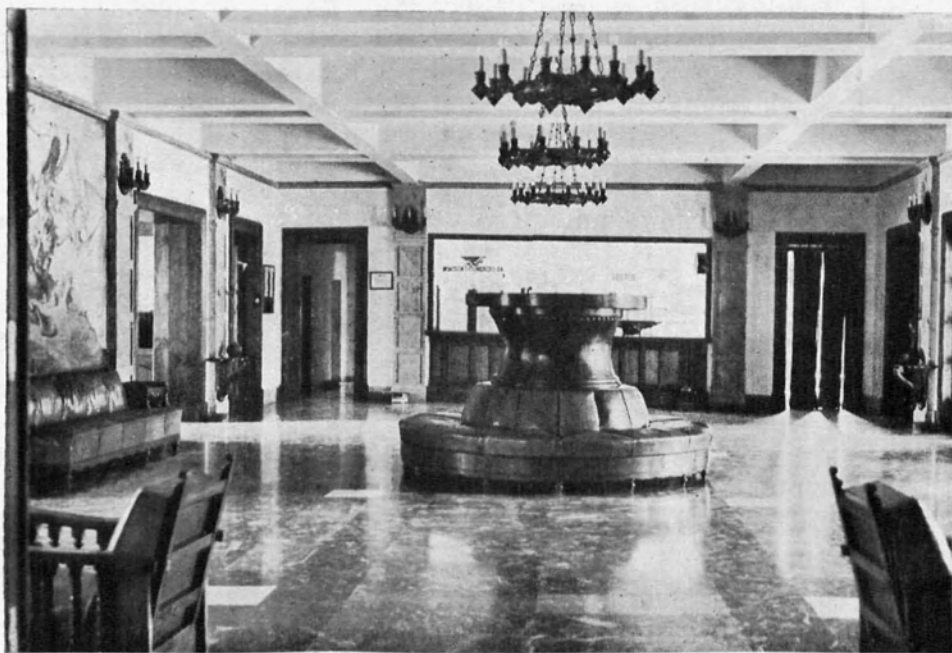
Interior del edificio
