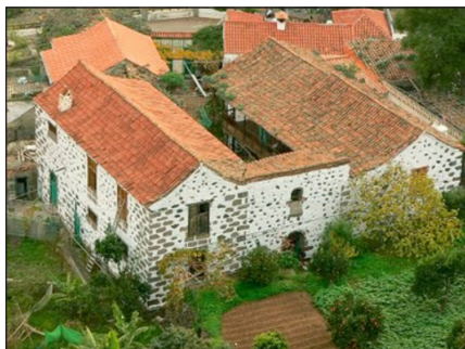
Casa Cuartel de Colmenar
