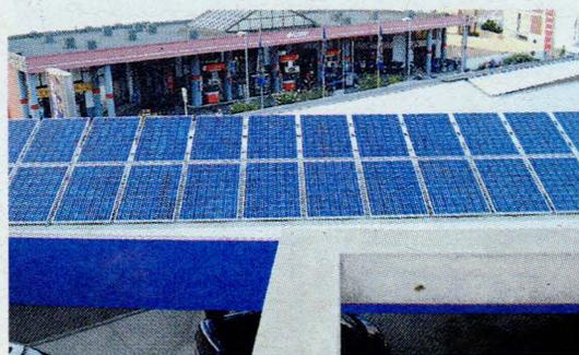
A la izquierda, primera instalación con módulos Siliken, realizada sobre la cubierta de una estación de servicio.
